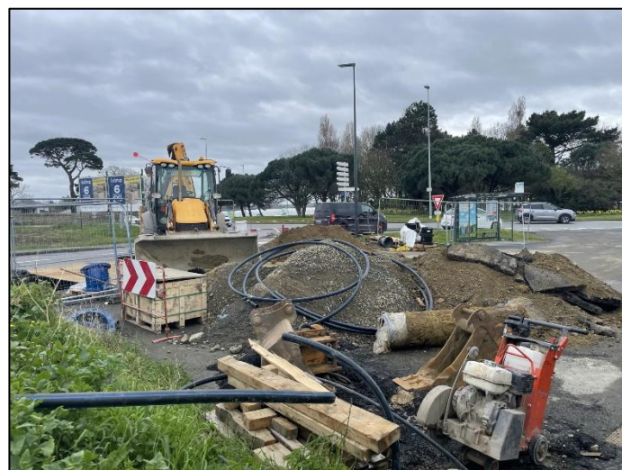
Figure 11 : travaux à proximité du laboratoire mobile, ZAC de la Houssaye.
