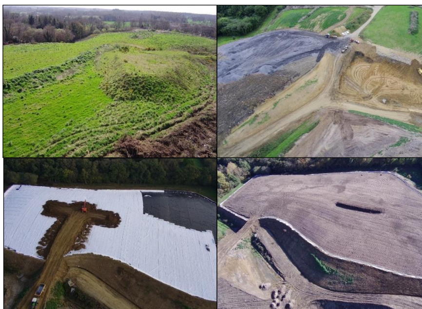
Figure 11 : Evolution des casiers d'enfouissement au cours des travaux de fermeture en 2025
