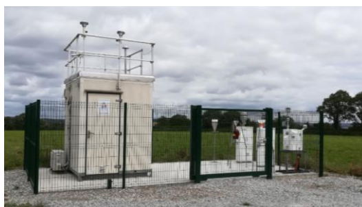
Site de mesures de Kergoff à Merléac (22)
