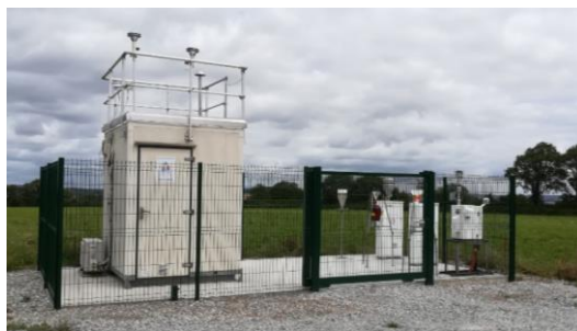
Site de mesures de Kergoff à Merléac (22)
