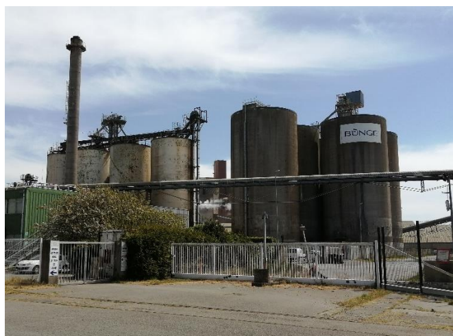
Figure 49 : Vue sur les installations de l'usine Bünge
