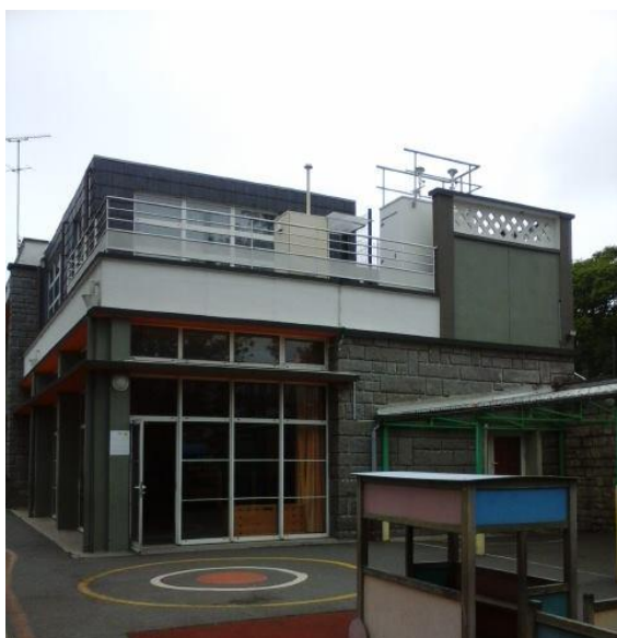
Figure 17 : Station de mesure à l'école Jean-Macé de Brest
