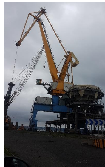
Figure 3 : Grue déchargement multi-vrac
