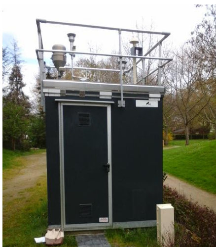
Site de mesures Pays Bas à Rennes
