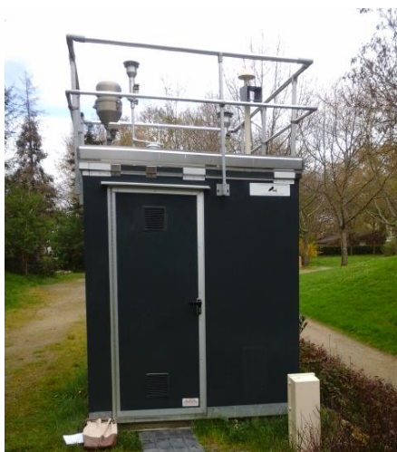
Site de mesures Pays Bas à Rennes
