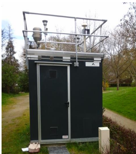
Site de mesures Pays Bas à Rennes
