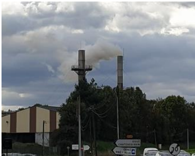
Figure 2 (ci-contre) : Vue des deux points de rejets principaux du site Coopedom
