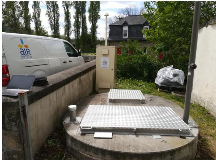
*Figure 5 : Cuve enterrée du poste de relevage.*
