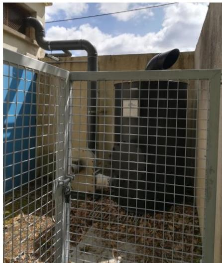
*Figure 6 : Installation de traitement de l'air du poste de relevage.*
