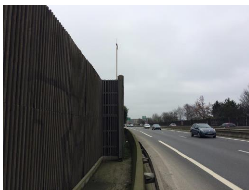
Mur antibruit séparant la voie des habitations
