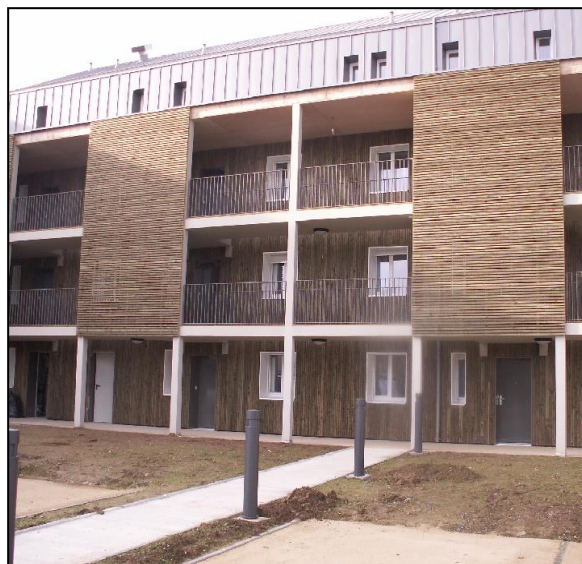
Façade du bâtiment BBC
