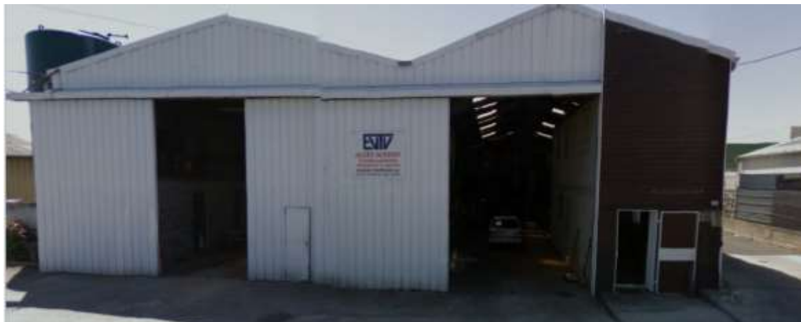
Figure 1 : Bâtiment réservé au traitement des eaux hydrocarbonées – Vue de la rue du Clos Baron
